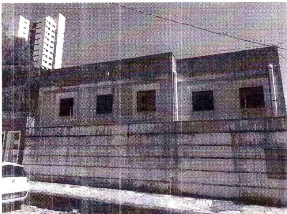
Trecho de complemento de alvenaria de 1/2 vez:
